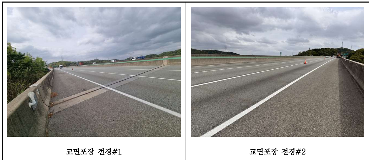
【사진 23.3.20】 교면포장 전경
