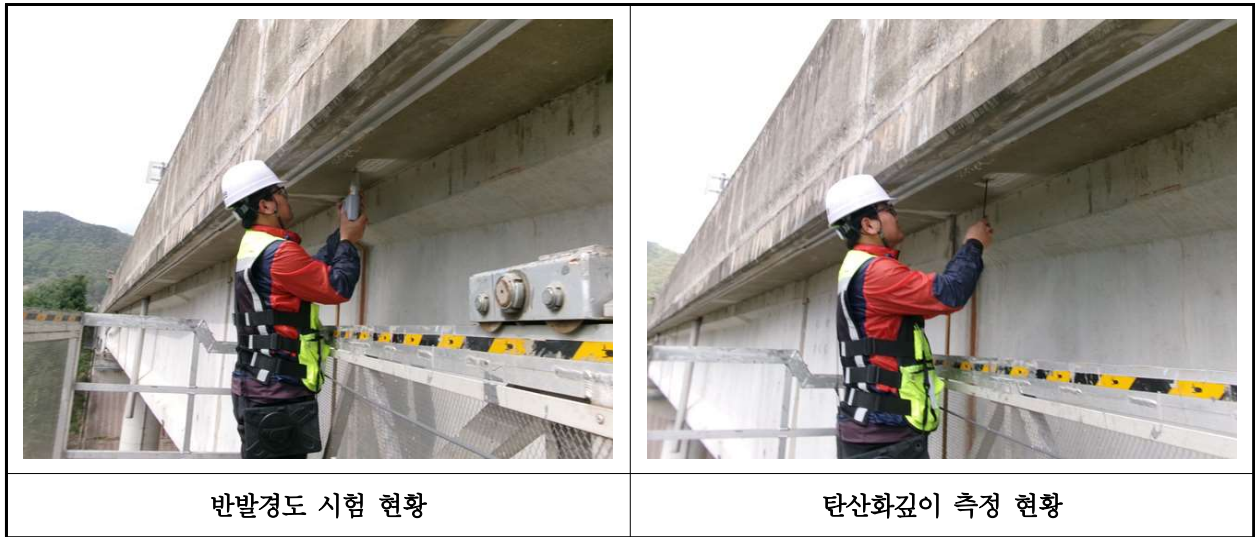
【사진 23.4.1】 콘크리트 내구성조사 현황
