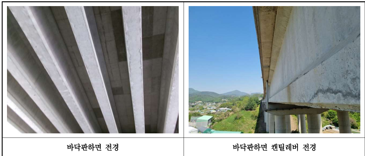
【사진 23.3.2】 바닥판하면 전경
