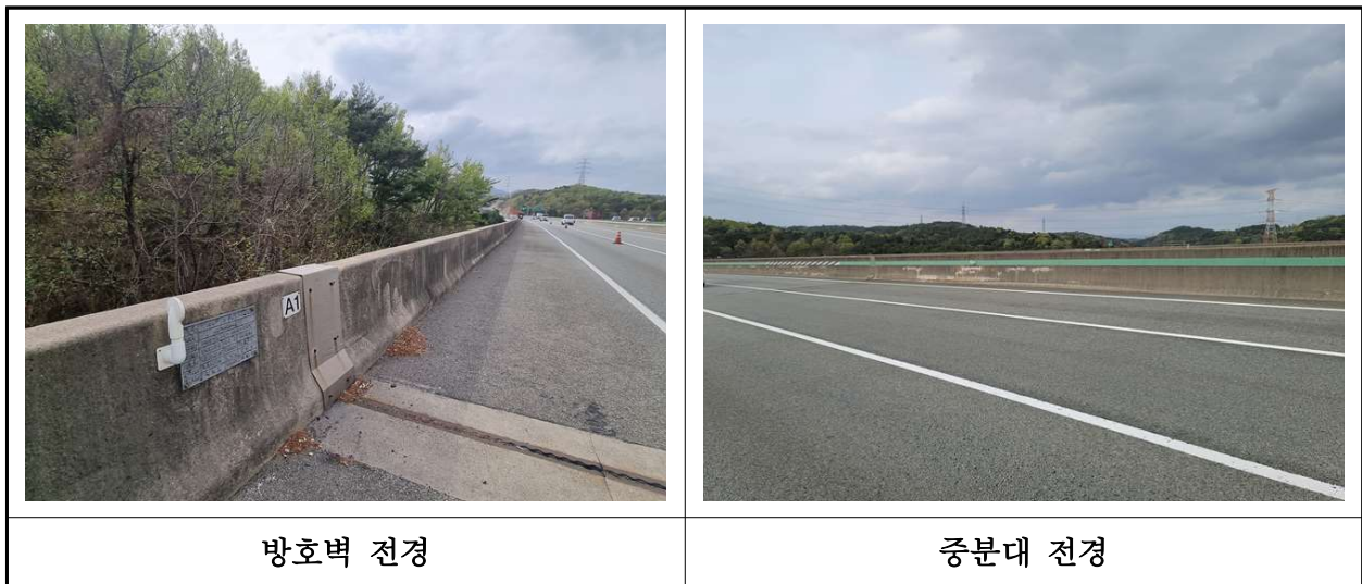
【사진 23.3.24】 방호벽 및 중분대 전경
