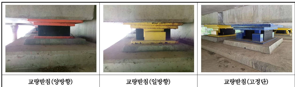
【사진 23.3.13】 교량받침 전경
