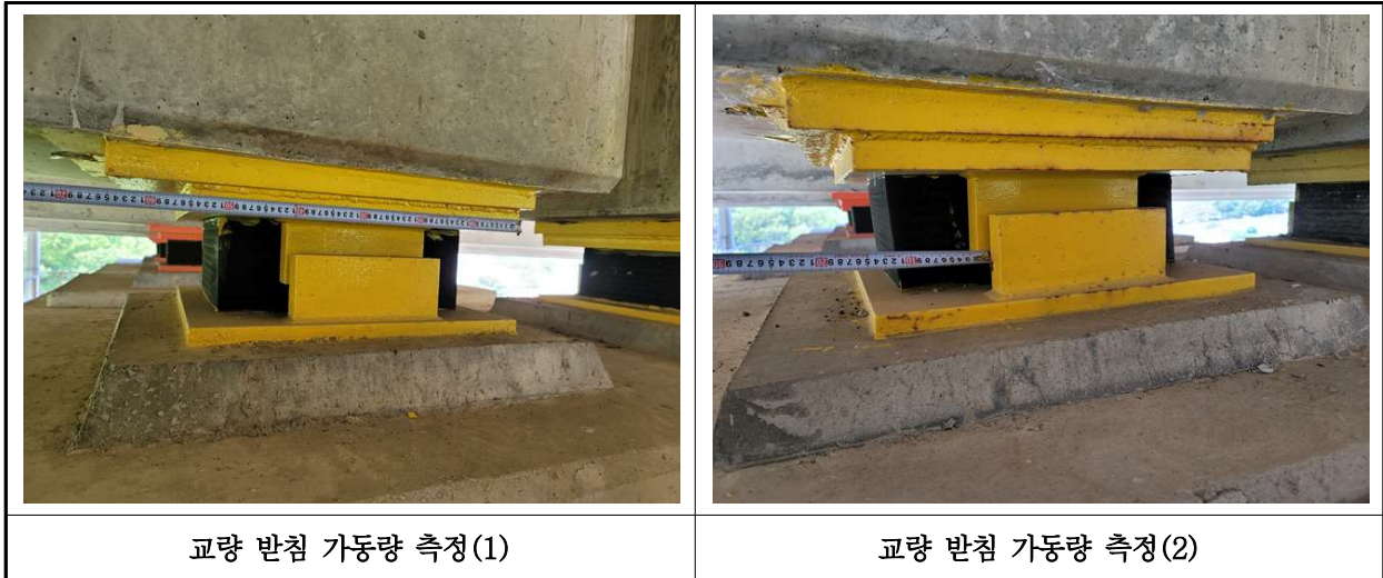
【사진 23.3.16】 교량받침 이동량 측정
