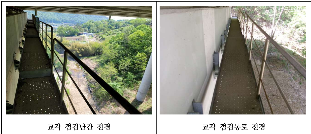
【사진 23.3.26】 교량 점검시설 전경
