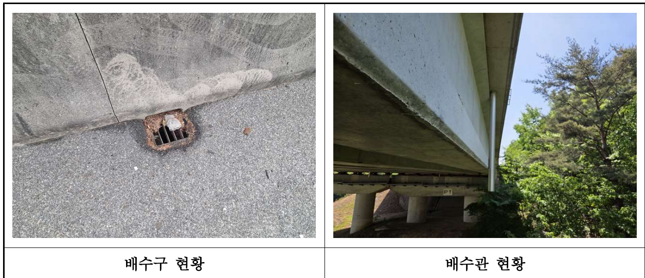
【사진 23.3.22】 배수시설 전경
