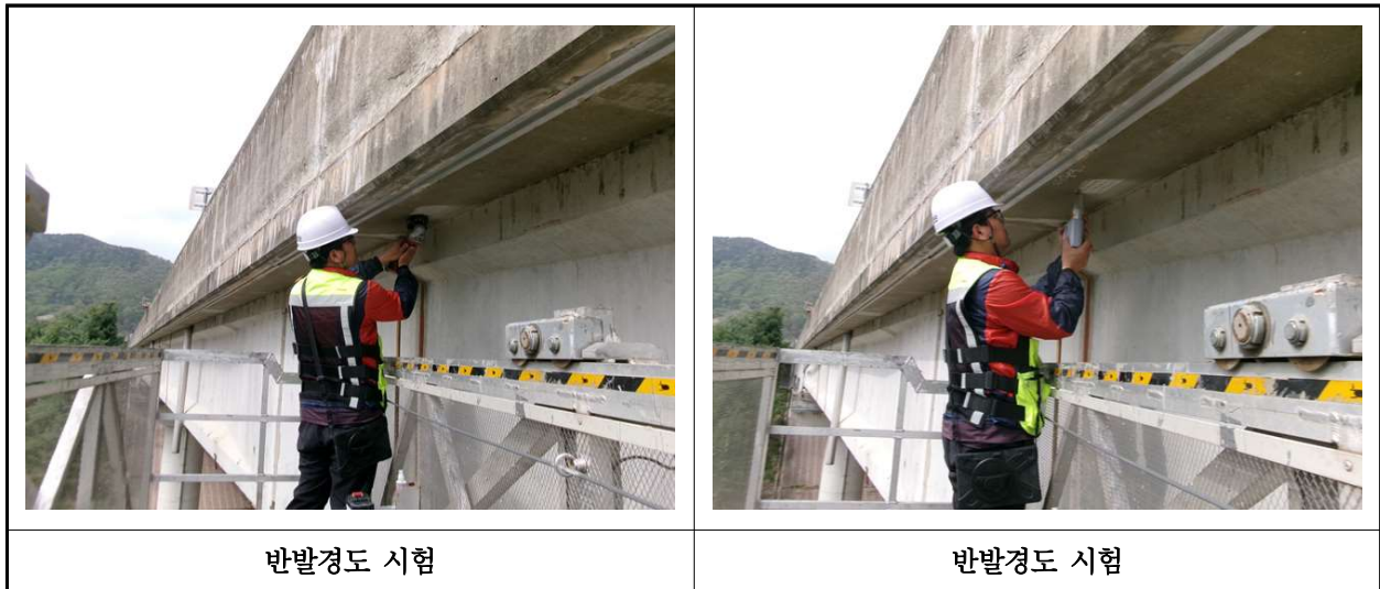
【사진 23.4.2】 반발경도시험 현장사진
