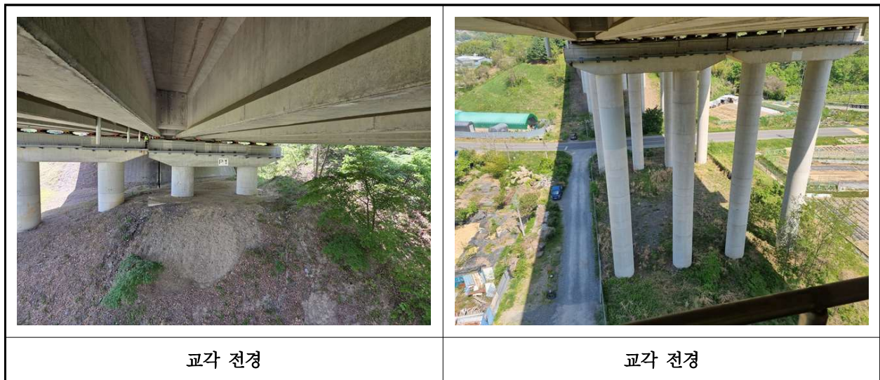
【사진 23.3.10】 교각 전경
