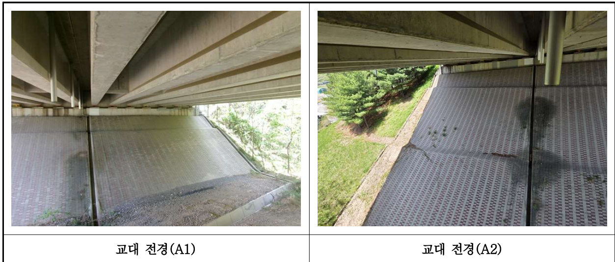
【사진 23.3.8】 교대 전경
