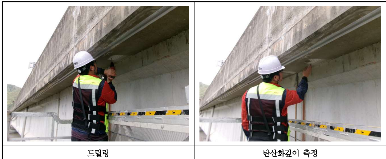
【사진 23.4.3】 탄산화 깊이 측정 현장사진
